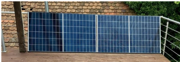
Bild: Zwei Steckermodul-Geräte ca. 30 Grad schräg an einer Brüstung, Copyright Bär
